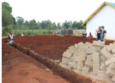
Verena und Michael beim Spatenstich
