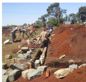
| Baustart im Mai 2017
