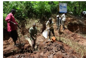
Arbeiter aus Kamobo bei der Erschließung der Quelle
