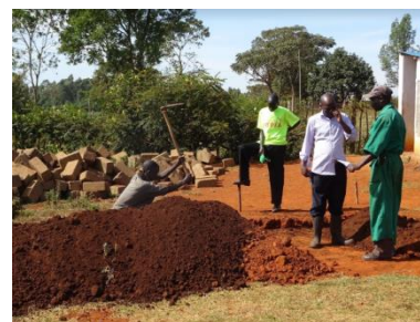
Baubesprechung zwischen den Arbeitern und unserem Bauleiter
