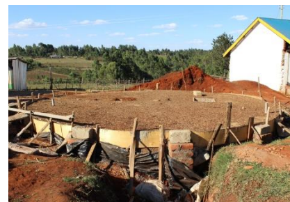
Im Februar 2018 wurde die Zisterne fertig, danach folgte die Trocknung
