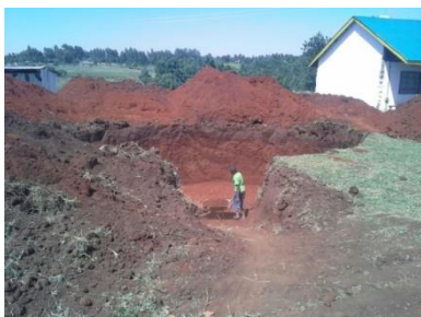
Grabungsarbeiten für die Errichtung der Zisterne
