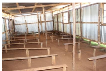
Der neue Speisesaal
