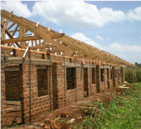
Die ersten vier Klassenräume werden fertiggestellt.
